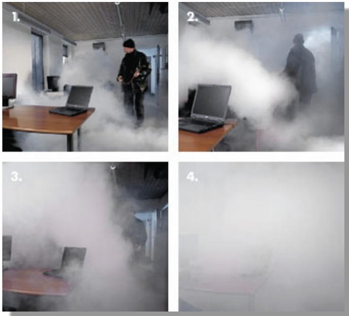
Szene eines Einbruchversuchs. Der Trockennebel sorgt dafür, dass binnen weniger als ca. 20 Sekunden nach einem Einbruch die geschützten Bereiche komplett vernebelt werden.
